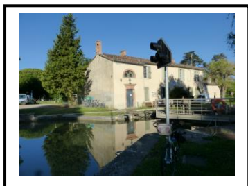
Km 6 : Ecluse de Négra
